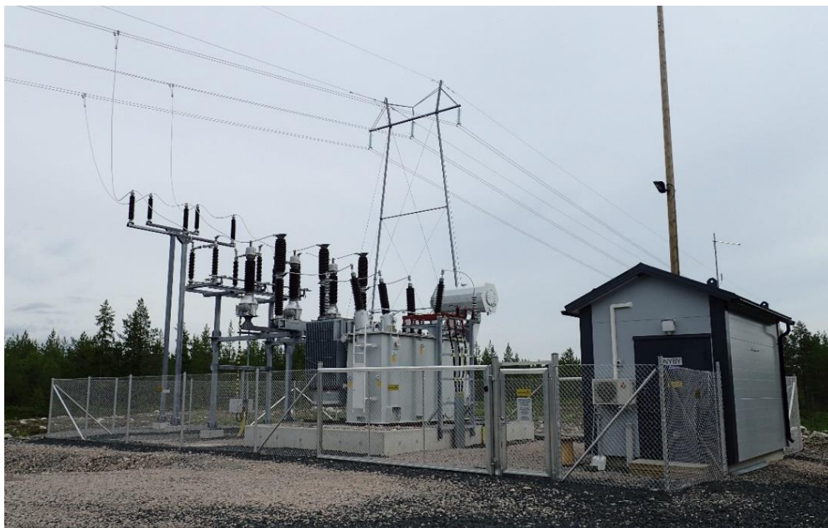
Kuva 8. Esimerkki tuulivoimapuiston sähköasemasta.
