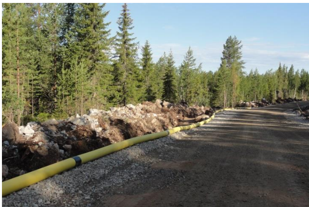
Kuva 6. (Vasemmalla) Esimerkki tuulivoimapuiston rakennus- ja huoltotiestä. Teitä käytetään muun muassa betonin, soran ja voimaloiden komponenttien kuljetuksiin sekä tuulivoimapuiston käyttövaiheessa huoltoajoihin. Maakaapeli sijoitetaan ojakaivantoon tien reuna-alueelle. (Oikealla) Tuulivoimalan osia kuljetetaan erikoiskuljetuksina. (Kuvat: Ville Suorsa / FCG).
