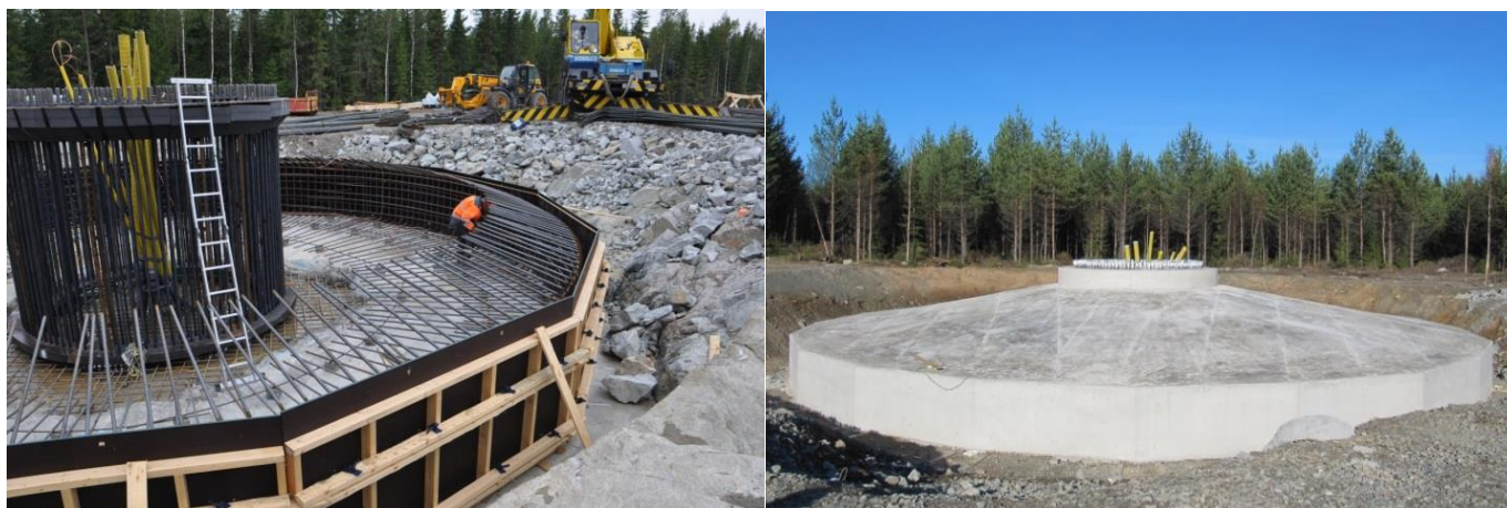
Kuva 10. Tuulivoimalan perustusten rakentamista. (Kuvat: Leila Väyrynen, FCG)
